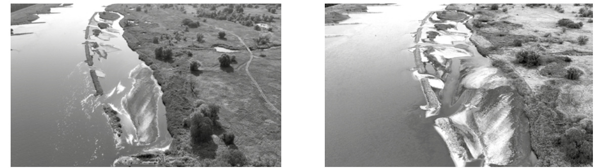
Abbildung 4: Parallelwerk bei Reitwein bei niedrigen Wasserständen (Quelle: WSA Oder-Havel 29.08.2024 und 10.09.2024)
