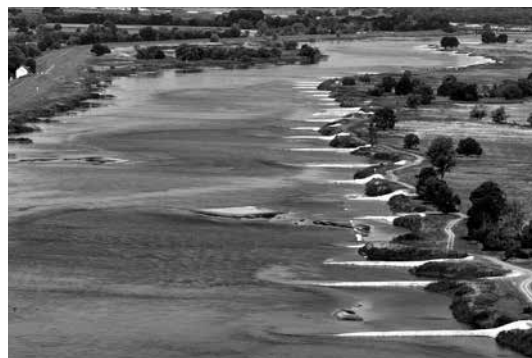
Abbildung 1: Luftbilder – Sandablagerungen, Od-km 647 und 608,8 (Quelle: WSA Oder-Havel 27.07.2023 und 25.09.2015)
