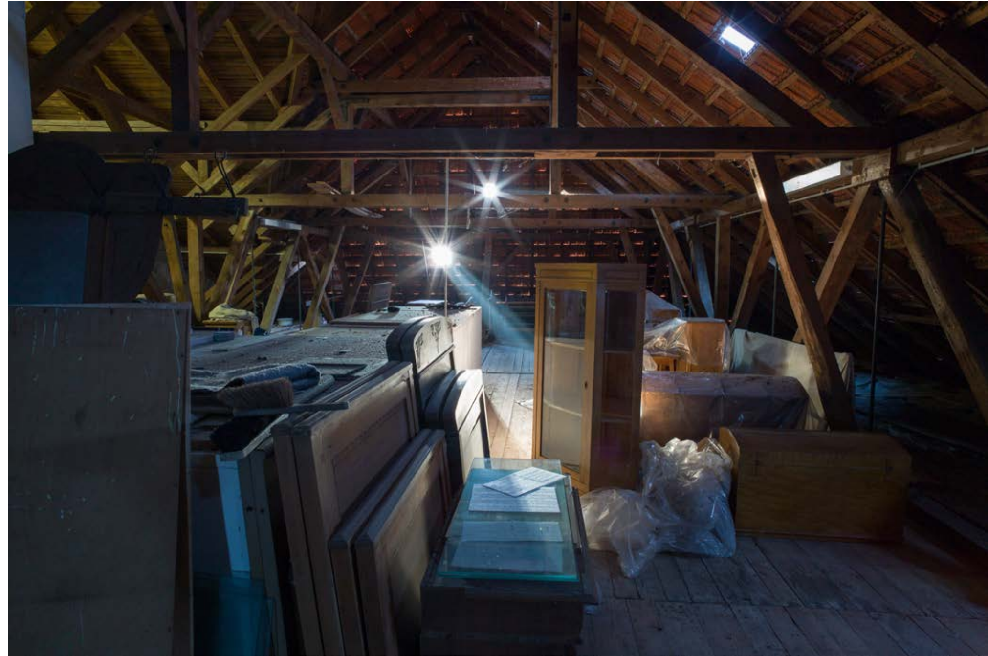
Der Dachstuhl wurde als Lagerraum für Sammlungsgut genutzt.
