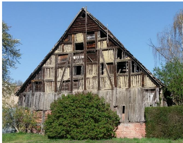
Abbildung 15: Scheune, Alttornow 17, Giebelseite, 2019
