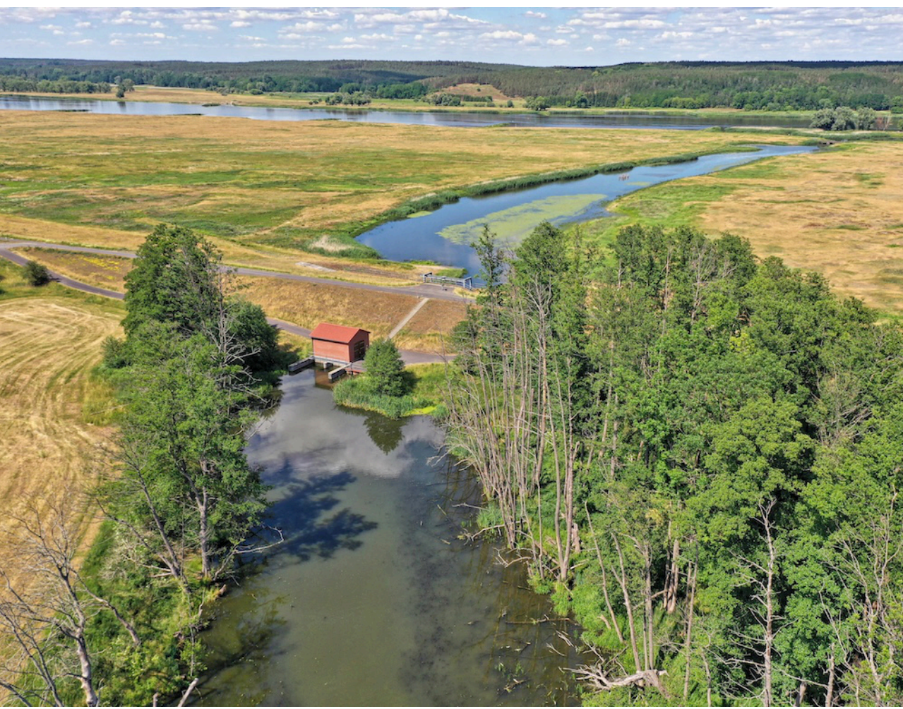
Am Deichsiel Güstebieser Loose beginnt der Neue Oder-Kanal. Die Alte Oder wurde vom neuen Oderstrom abgeschnitten. Das Deichsiel ist einer der bedeutendsten Orte in der Wasserbaugeschichte des Oderbruchs.
